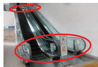
<ラッピング箇所(ガラス面)>
