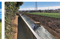
土砂流出防止対策／都筑区
